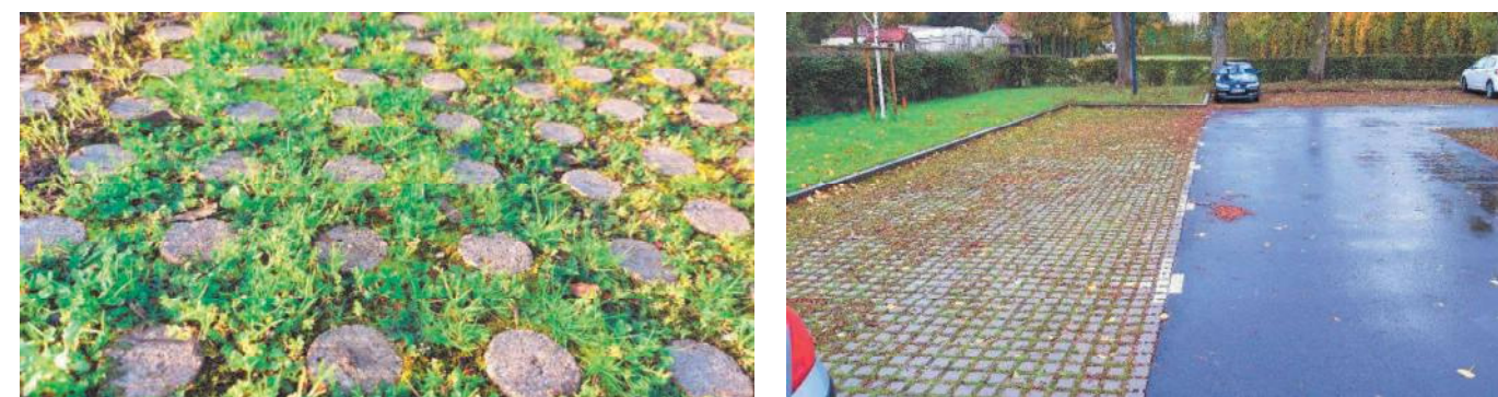
Réalisation d'un parking enherbé
