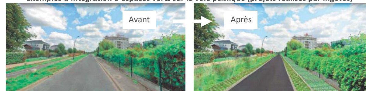
Opération de désimperméabilisation sur la voie publique (trottoirs, chaussée)
