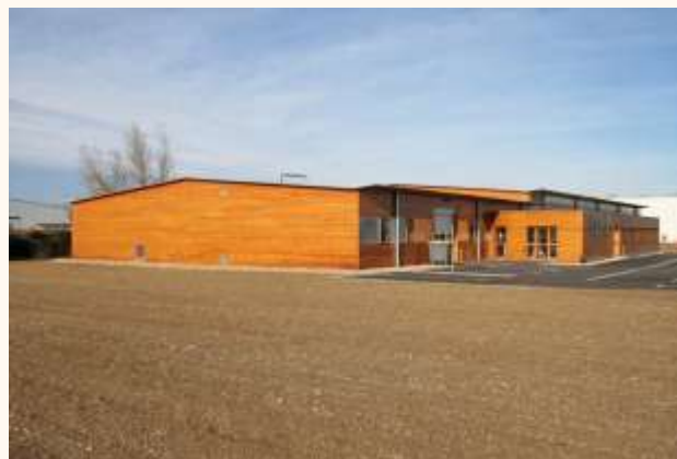
Atelier de menuiserie S.A.M.A. à Mazères (Ariège)
