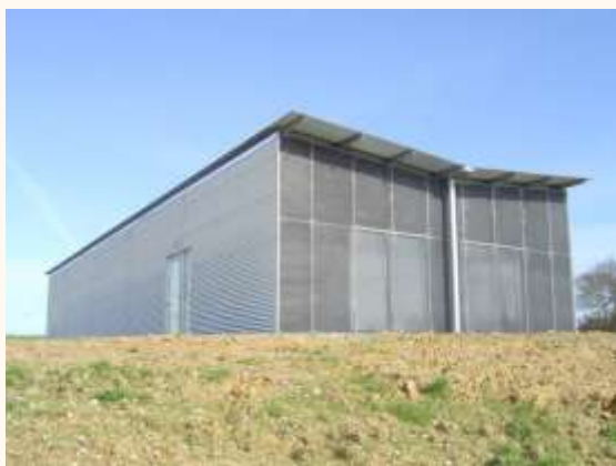
Atelier Relais (bureaux et hangar) à Puceul (Loire-Atlantique)
